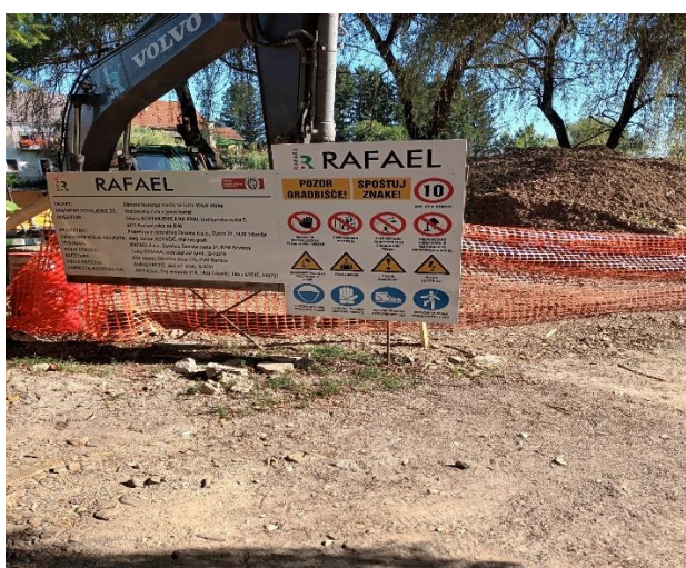
Fotografija št. 6: Označeno gradbišče pri južnem mostu, dostop strogo prepovedan
